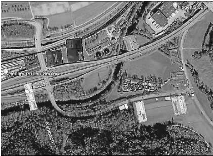
Vollsperrung der L 1201 Richtung Hochdorf
