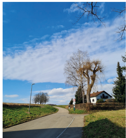
Abb. 30: Einstieg Radweg nach Wernau
