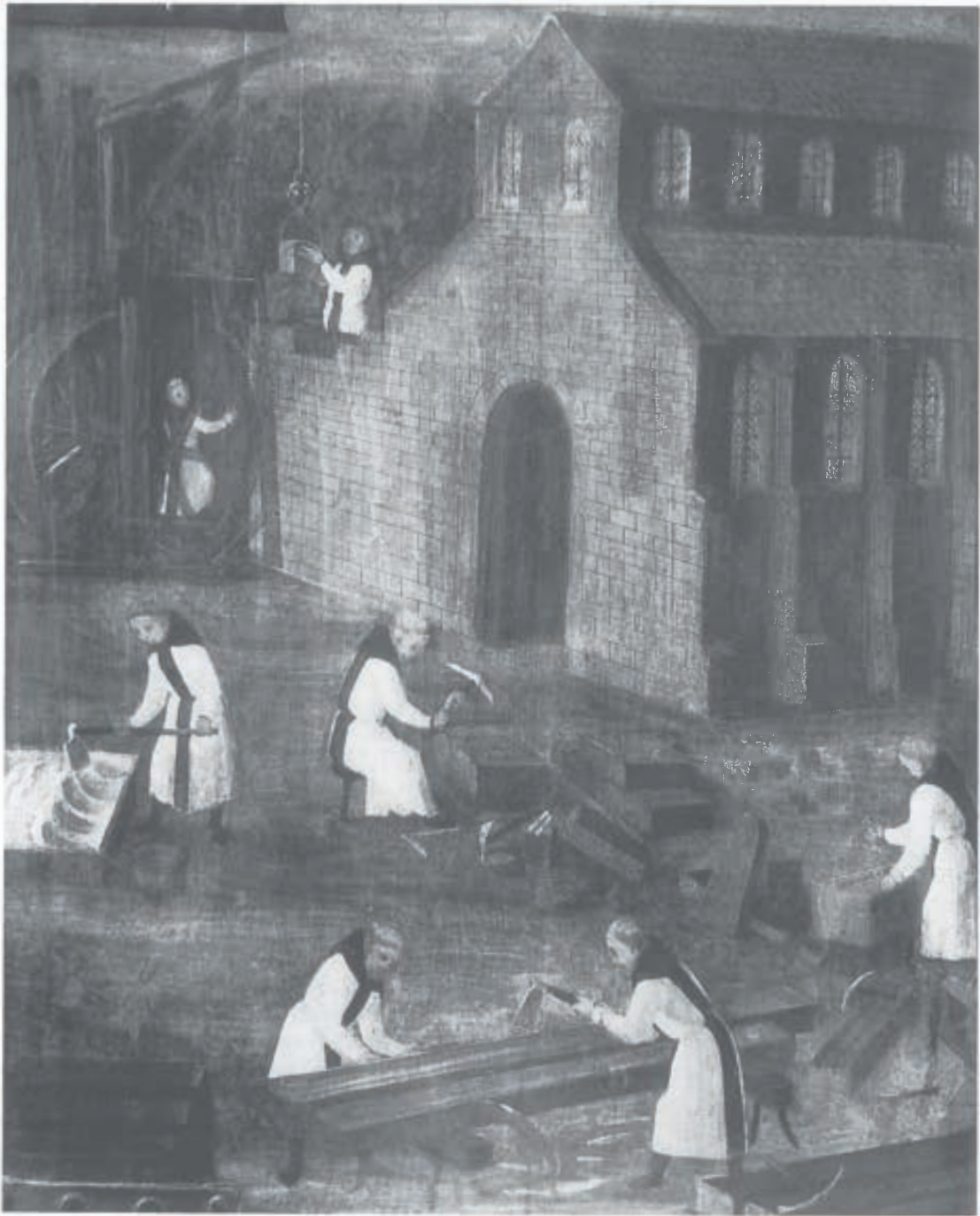
Zisterziensermönche im Ordenshabit bei der Arbeit (1450)
