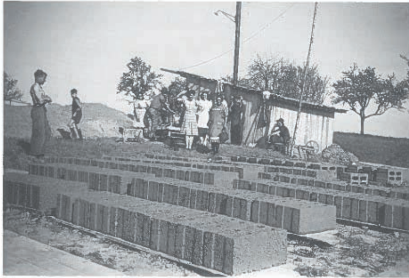
Fertigung von Hohlblocksteinen 1951
